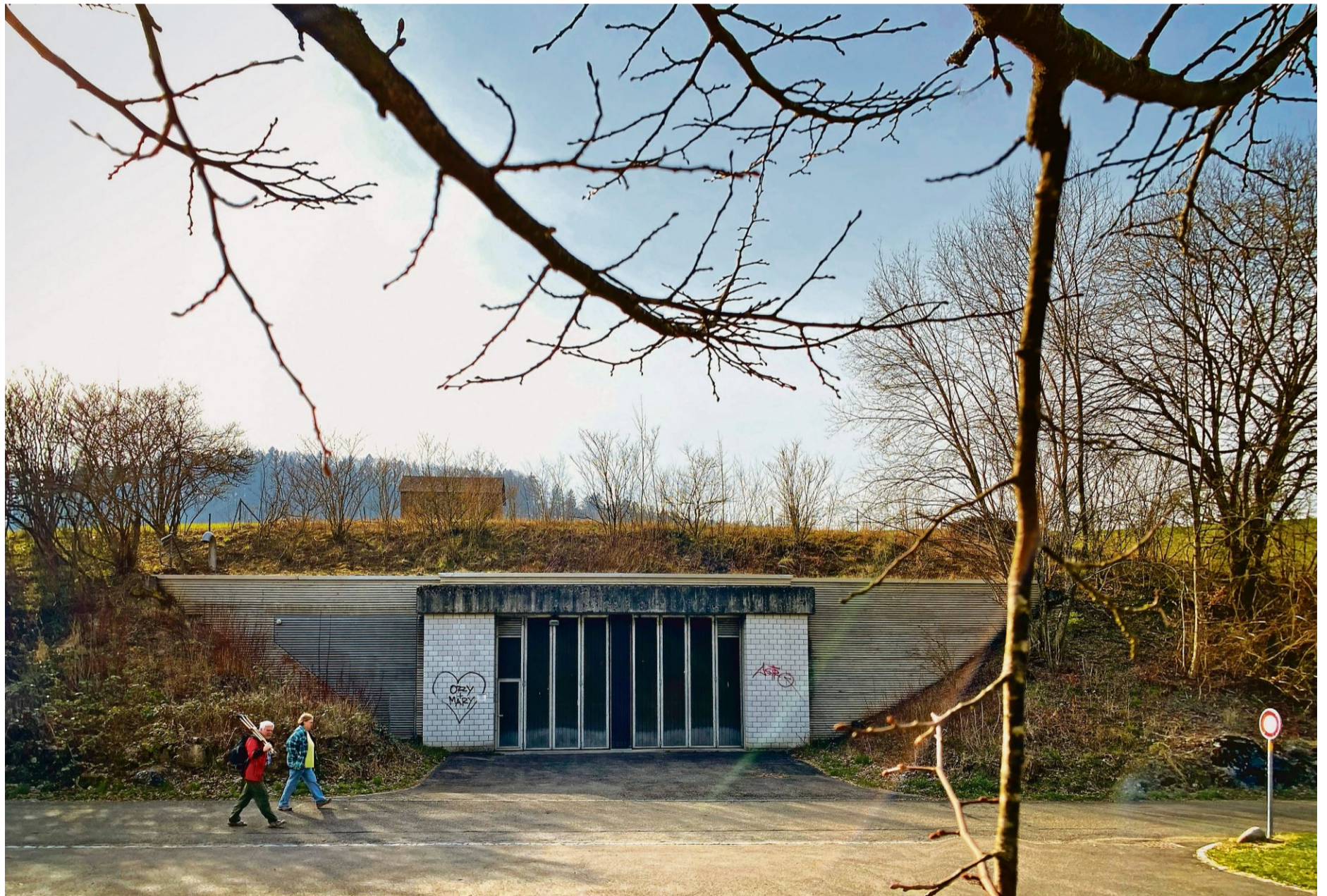
Bunker am Dorfrand: Der Eingang zur ehemaligen Lufttrennanlage der Armee in Madetswil bei Russikon. Foto: Urs Jaudas
